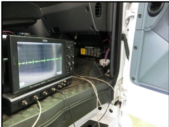
Abbildung 65: Störstrommessung einer CAN-Leitung in der Fahrerkabine
