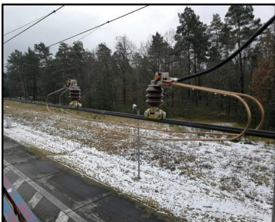
Abbildung 82: Installierter mechanischer Kontaktbügel
