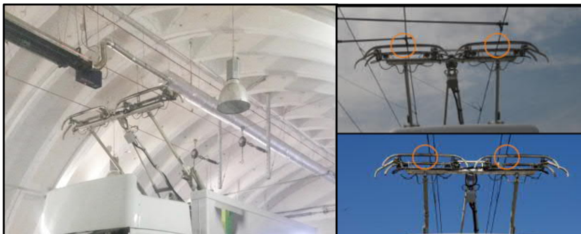
Abbildung 76: Fahrleitung im Shelter / Umbau der Fahrleitung auf der Teststrecke
