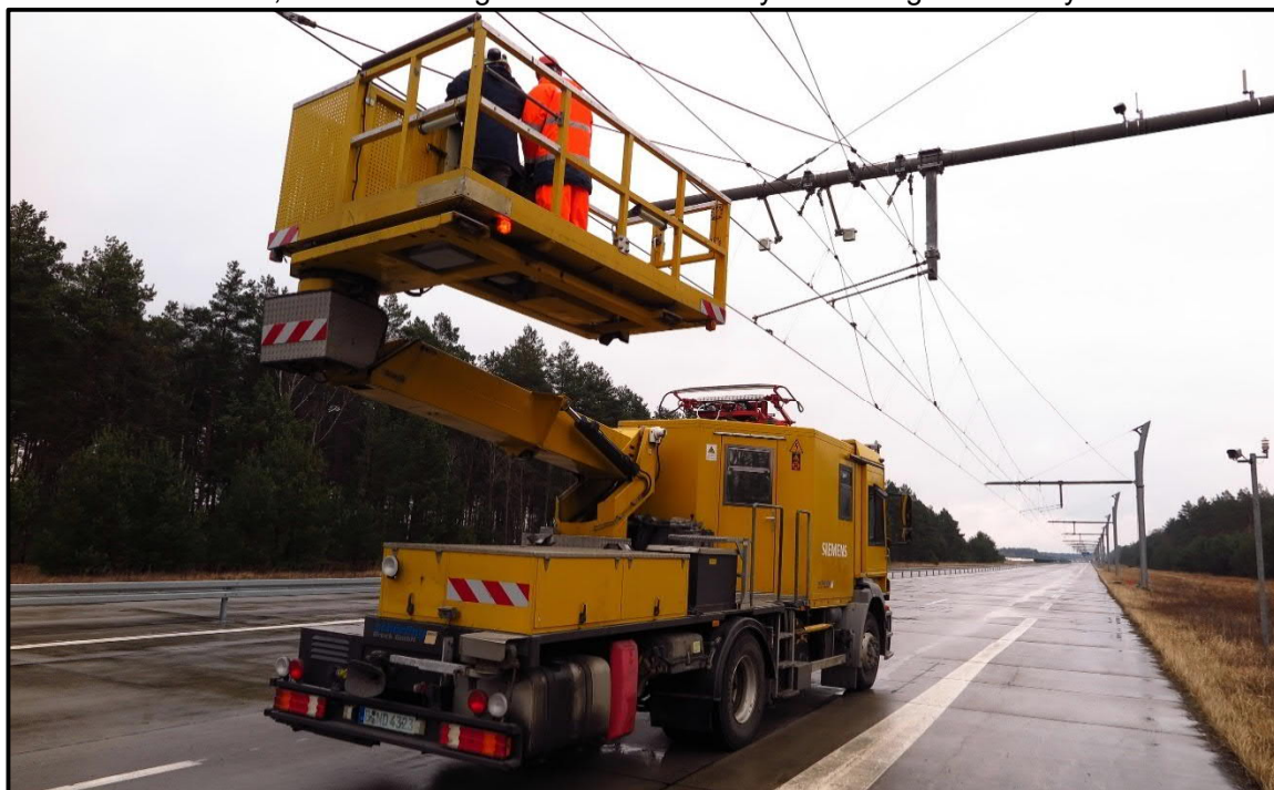
Abbildung 10: Oberleitungsinspektion auf der Versuchsanlage in Groß Dölln mit Zweiwegefahrzeug für Oberleitungsarbeiten
