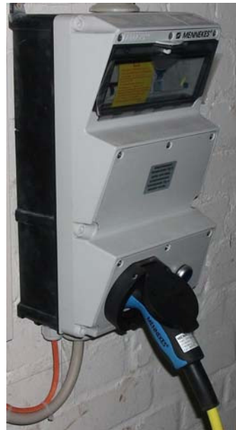
Abbildung 33 - Ladeinfrastruktur Version 01, der AMEXX Home Charger von Mennekes
