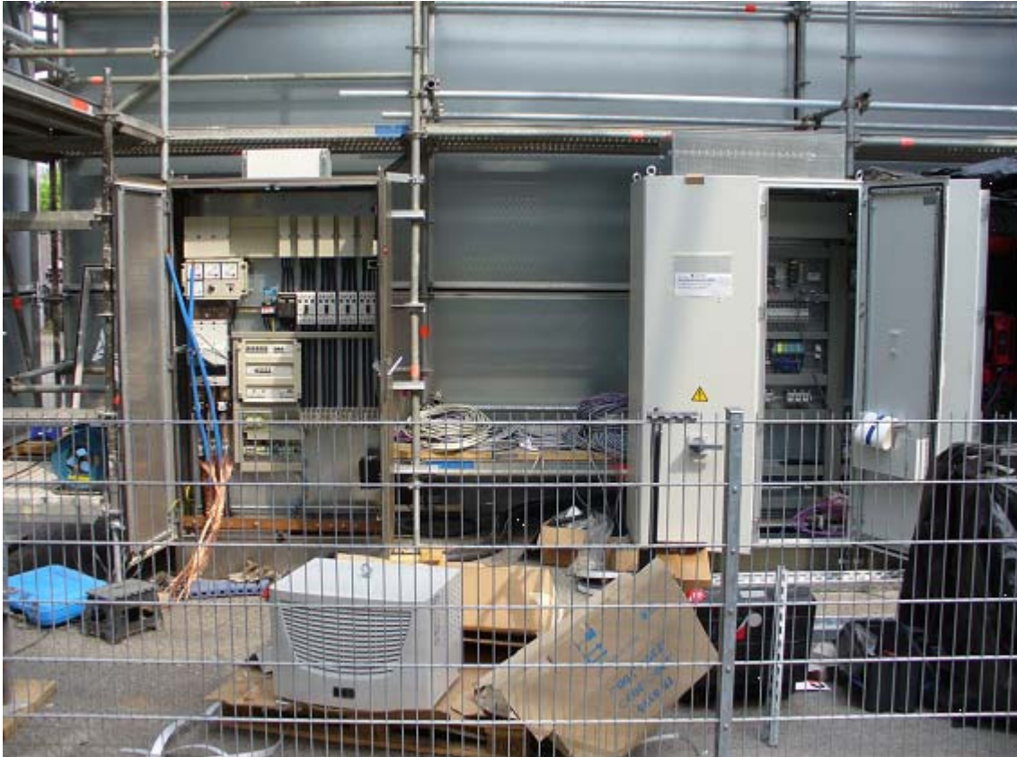
Abbildung 15: Aufbau Schaltschränke (links Übergabe Stromkreis, rechts Steuerschrank RBG)
