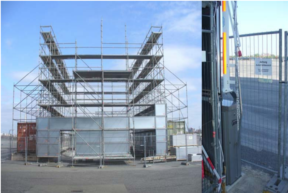
Abbildung 17: Errichtung der Einhausung und der Schranke, Anfang April 2011
