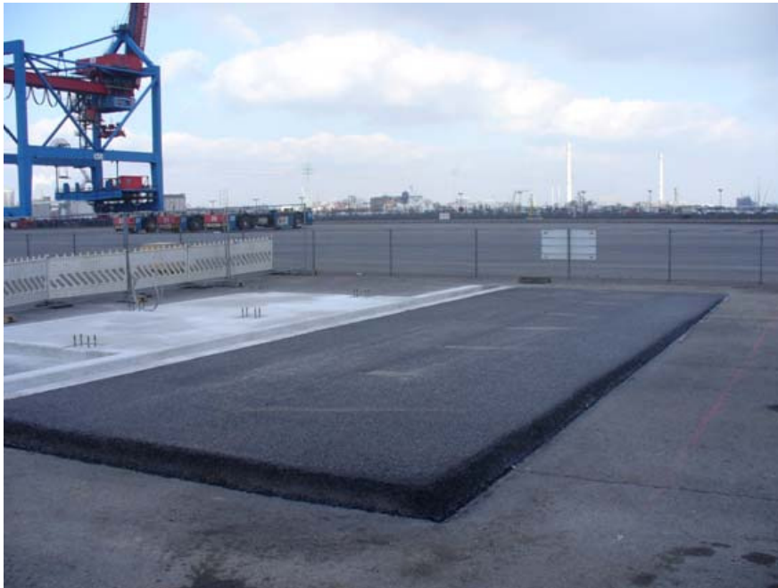
Abbildung 13: Fundament und Asphaltanrampung, Mitte März 2011
