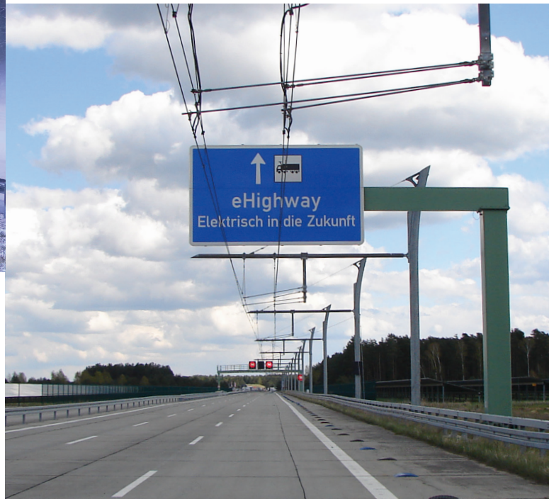
Die eHighway-Teststrecke von Siemens in Groß Dölln.
