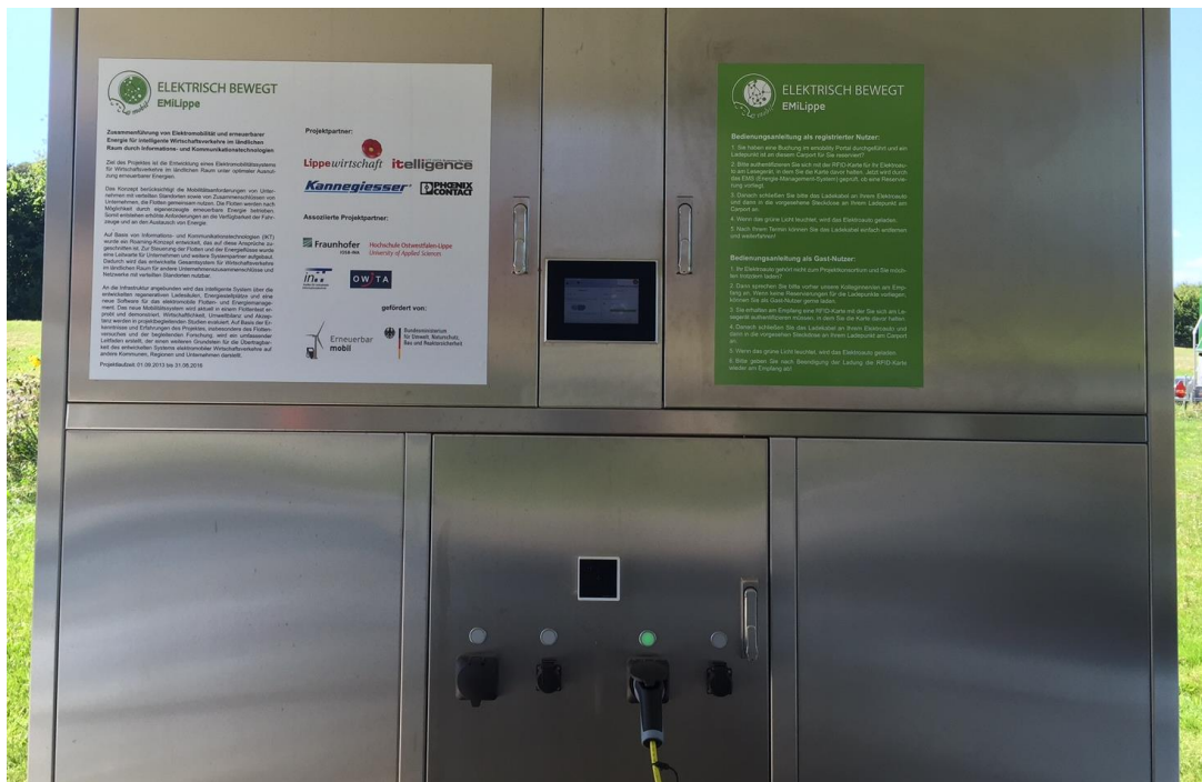
Abbildung 178: Schaltschrank Beklebung am Innovationszentrum in Dörentrup
