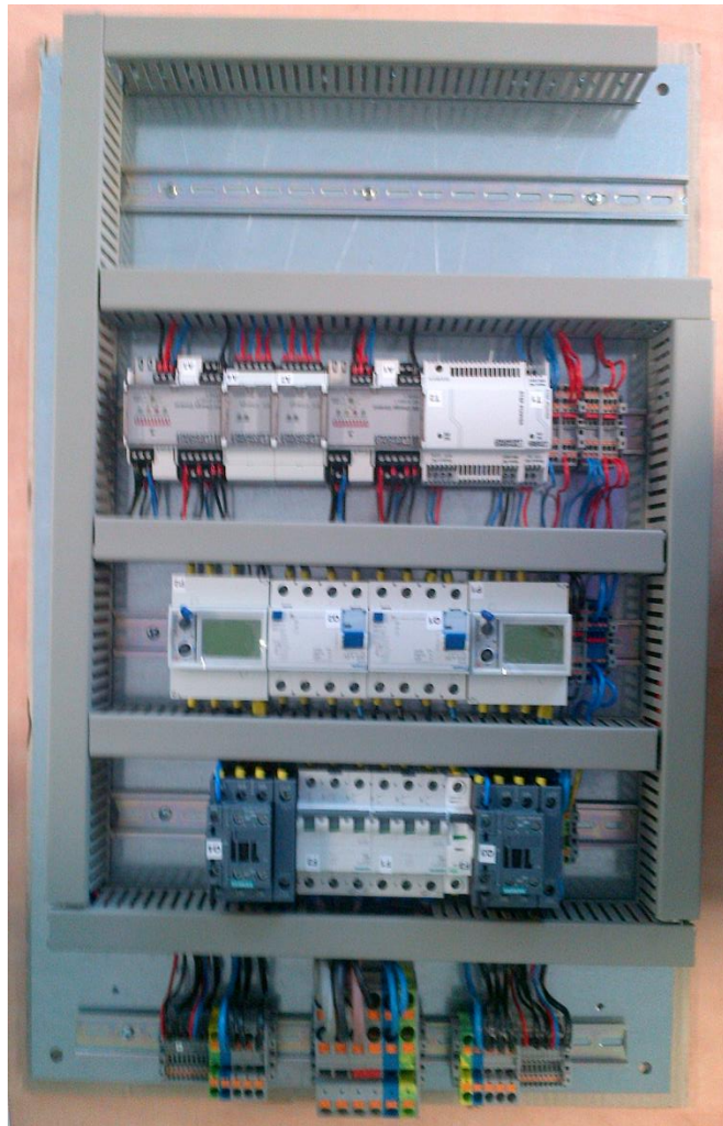
Abbildung 63: Montageplatte mit Schutz- und Schaltgeräten sowie Ladesteuerung
