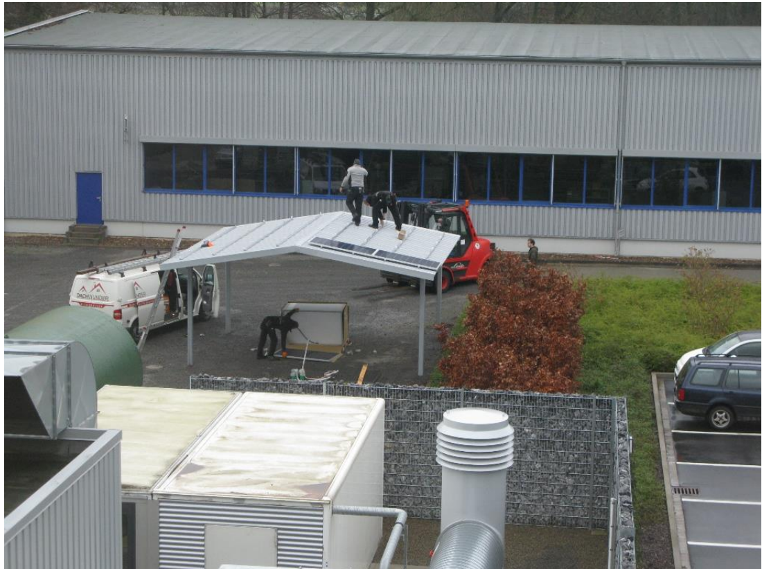
Abbildung 36: Aufbau des Prototypens auf dem Firmengelände der Herbert Kanngiesser GmbH
