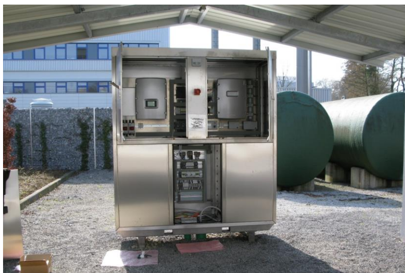
Abbildung 52: Steuerschrank (Prototyp) am Standort Kannegiesser ohne mittlere untere Steckwand
