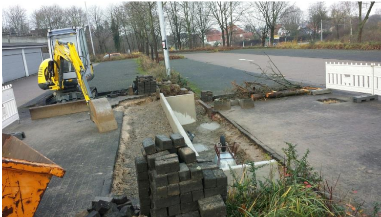
Abbildung 44: Carport – Fundamentarbeiten am Kreishaus (Detmold)
