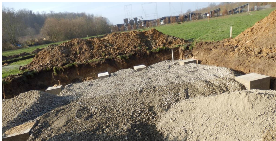
Abbildung 39: Fundamentbau am Carport in Dörentrup-Wendlinghausen
