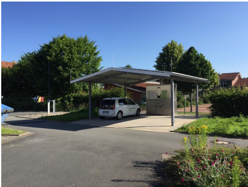
Abbildung 47: Carport – Carportanlage nach Abschluss der Baumaßnahme an der Hochschule OWL (Detmold)
