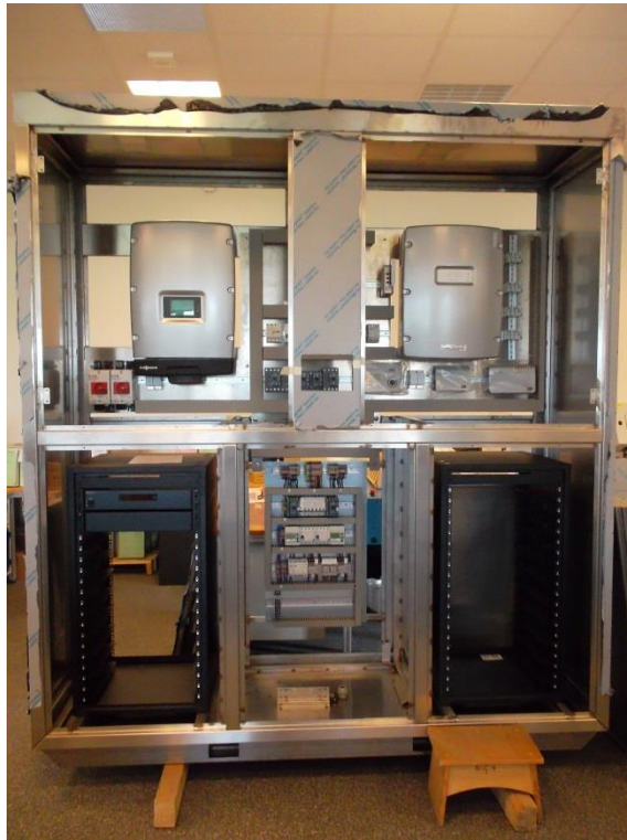
Abbildung 51: Montage des Steuerschranks im Projekt "EMiLippe"
