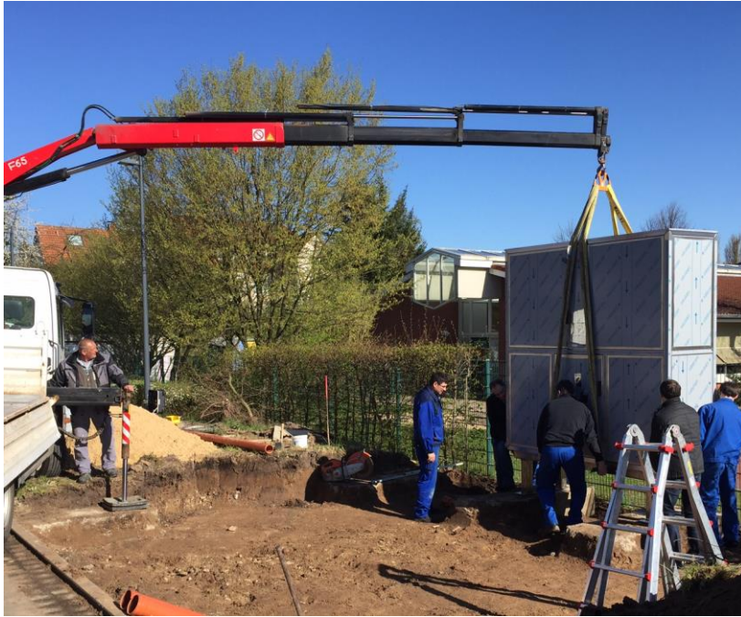
Abbildung 46: Carport – Aufbau des Schaltschrankes an der Hochschule OWL (Detmold)
