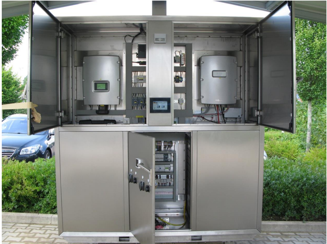
Abbildung 53: Aktuelle Ausführung vom Steuerschrank nach dem Re-Design
