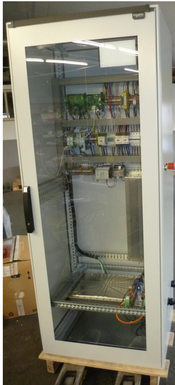
Abbildung 71: Schaltschrank für den Testaufbau der DC-Ladestation
