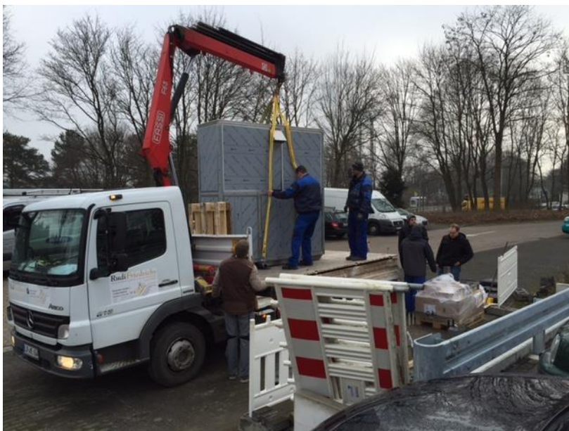
Abbildung 45: Carport – Aufbau des Schaltschrankes am Kreishaus (Detmold)
