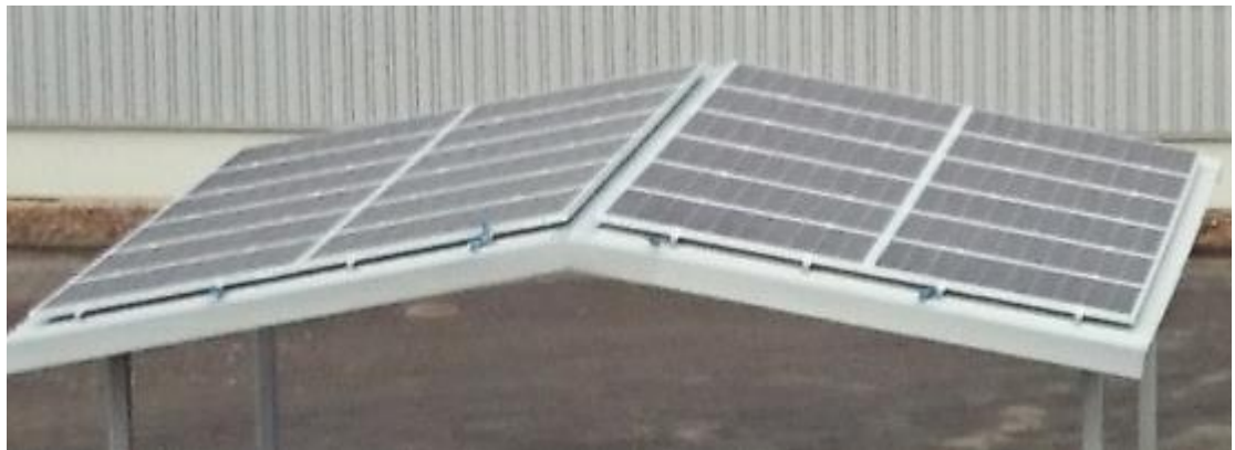
Abbildung 17: Solarmodule auf dem Prototyp des Energiestellplatzes bei der Firma Kannegiesser
