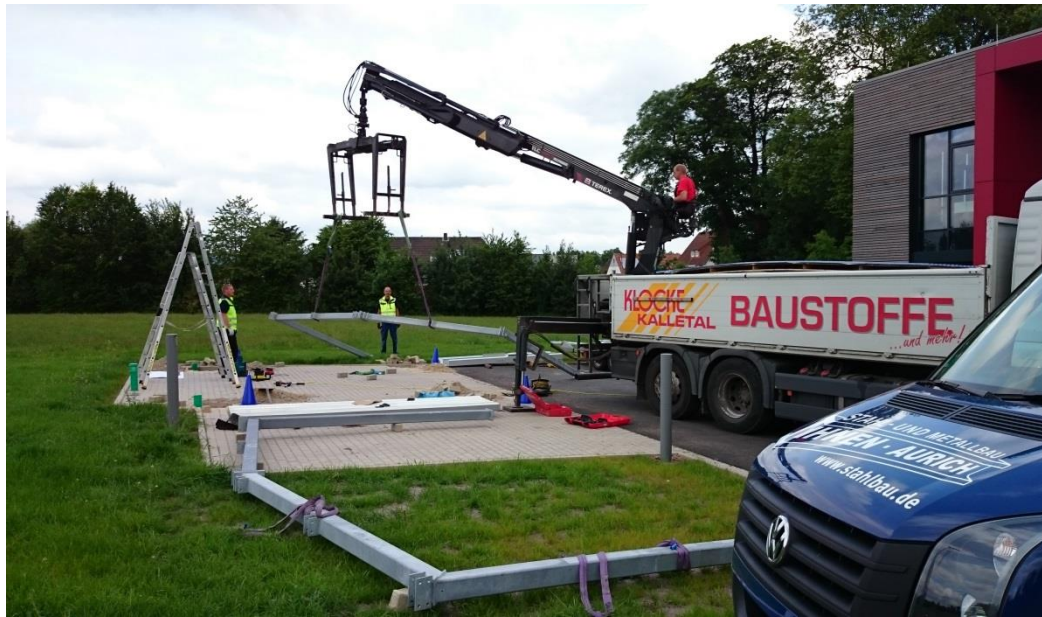
Abbildung 40: Gerüstaufbau am Carport in Dörentrup-Wendlinghausen
