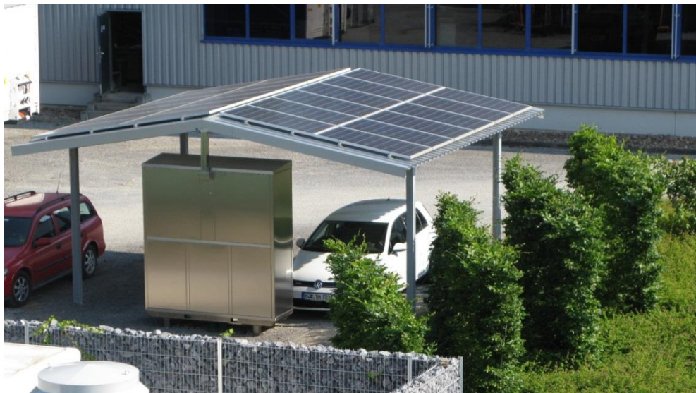
Abbildung 37: 1. Carport - Fa. Kannegiesser (Vlotho)
