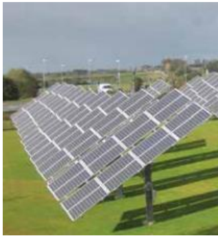
Abbildung 23: Halterung für mehrere PV-Module
