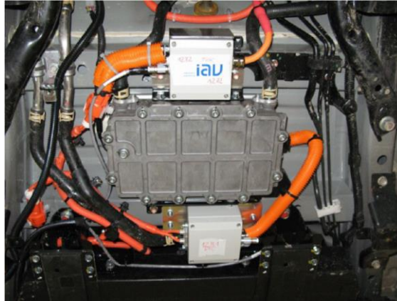
Abbildung 3: Beispiel für die verbaute Hochvoltmesstechnik, hier Shunt zur Messung der Ströme an Heizelement und elektrischem Klimakompressor (Quelle: IAV GmbH)
