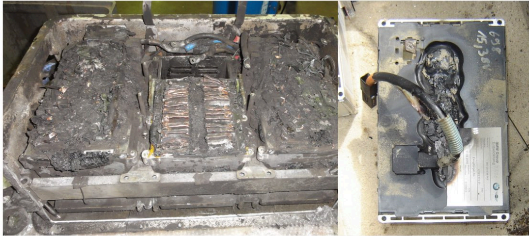
Abbildung 32: Beschädigte Batterie und beschädigtes Modul
