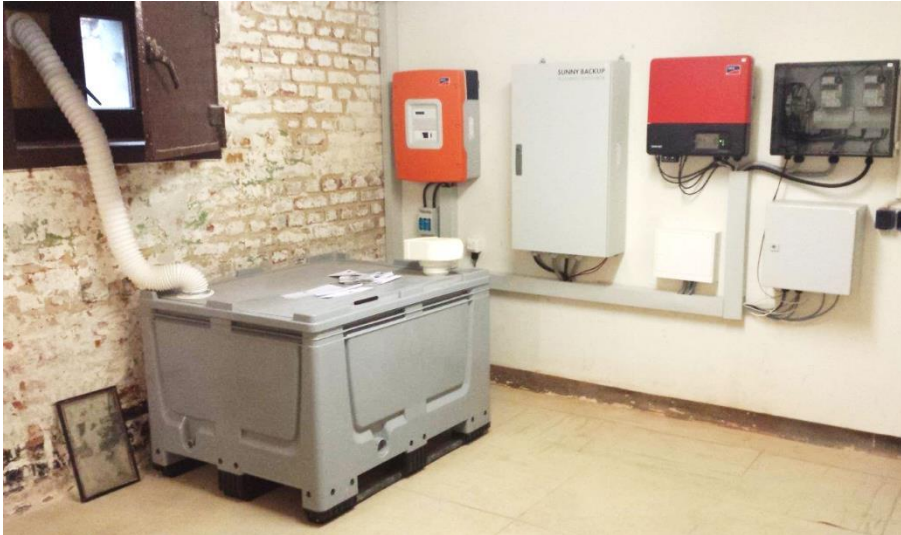
Abbildung 34: Aufbau stationärer Batteriespeicher
