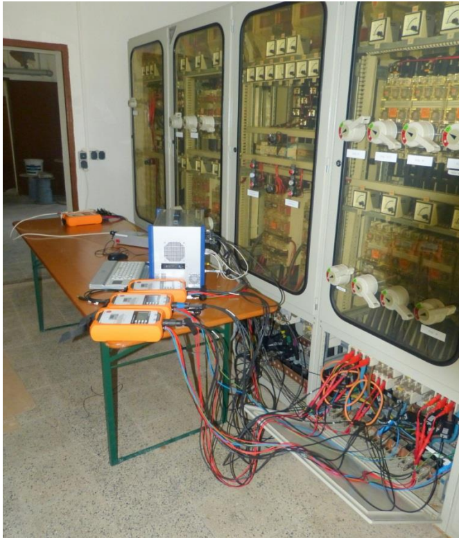
Abbildung 60: Netzmessungen im INNOPARK Kitzingen (TU Dresden, BEL Drive)
